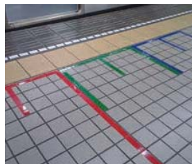
駅構内の誘導ラインとして
